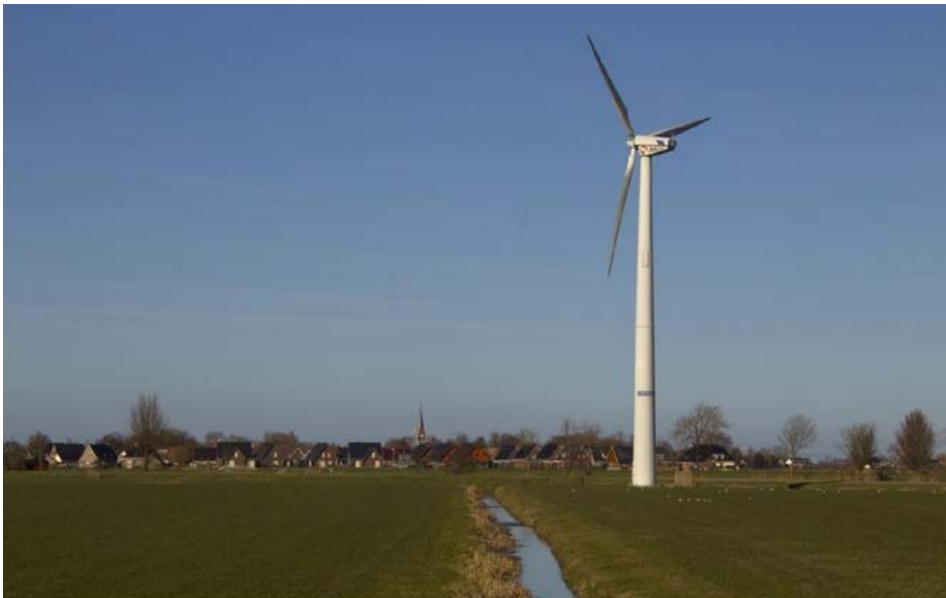
Dorpsurbine Reduzum met ashoogte van 36 meter en een rotordiameter van 51 meter. (Archief Leeuwarder Courant)
